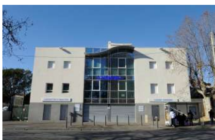
Immeuble Amphora Rd Pt/chemin de Ste Marthe
