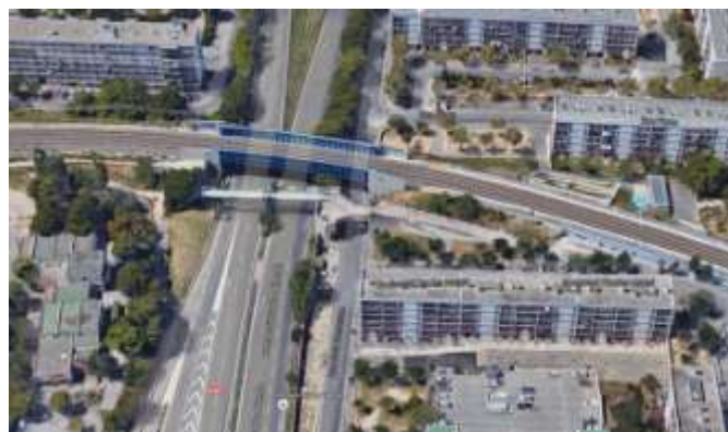
voie SNCF – rocade Allende
